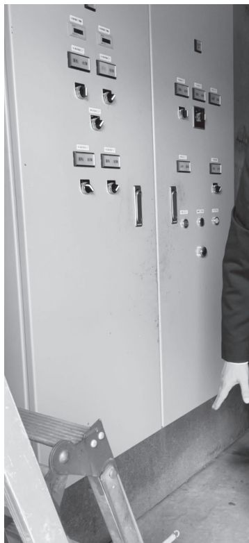
地面から配電盤までの高さを確認
