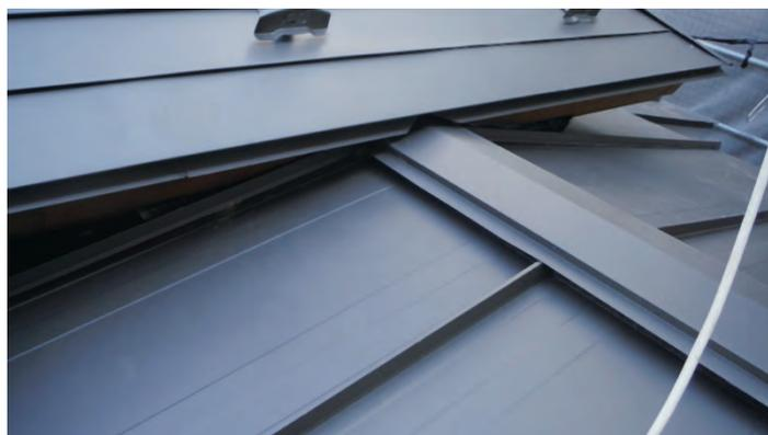
導入した折曲機で加工した屋根材
