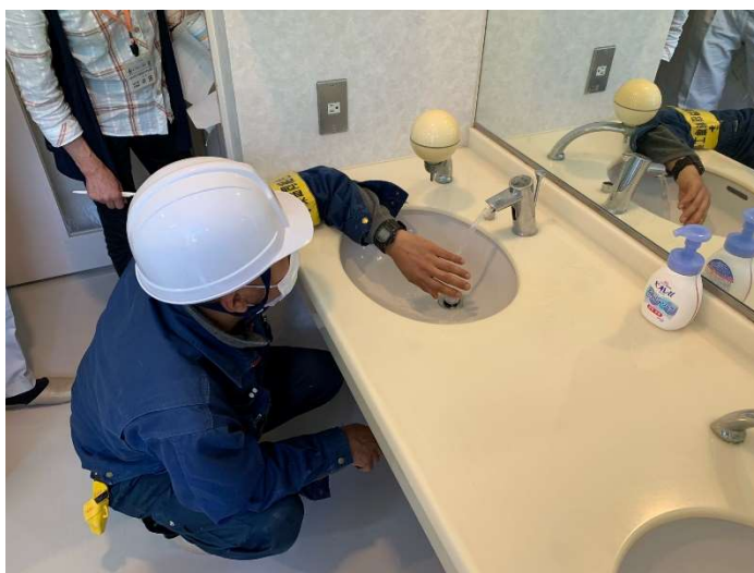
点検作業の様子
